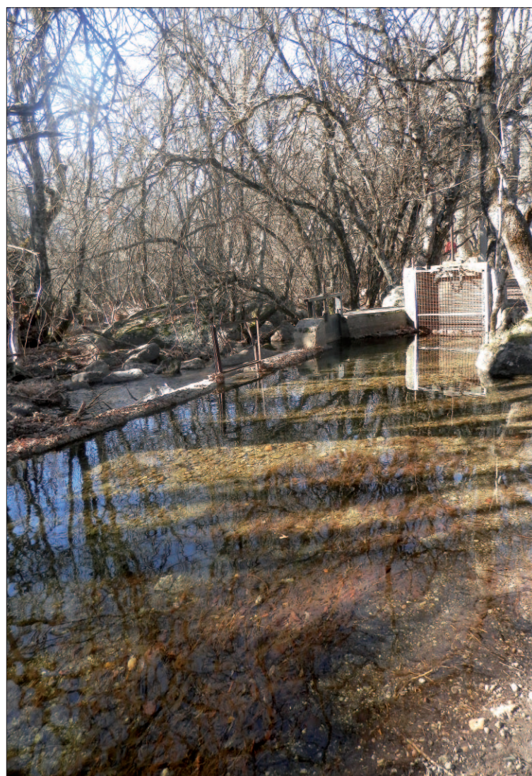
Aguas arriba del cauce del Río Cambrones aparece la Cacera Madre, el punto en el que se desvían parte de sus aguas para dar lugar a la cacera del Cambrones.
